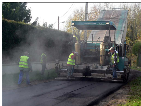
Réfection du chemin des foulons
