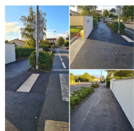
Trottoir rue du Vignoble
