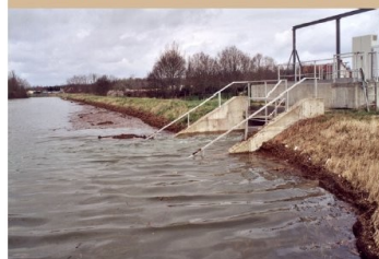
La digue d'Ouroux-sur-Saône (71)
