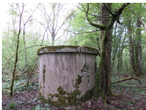
Cheminée d'aération de la rigole d'Aron
