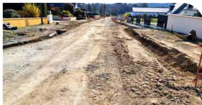
Travaux Rue des Etangs.
