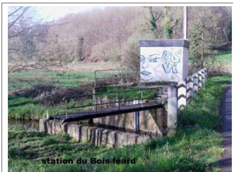
Station de mesure débit sur l'Arguenon en Jugon-les-Lacs
