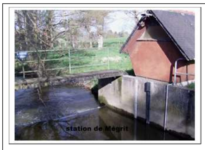
Station de mesure de débit sur la Rosette en Mégrit
