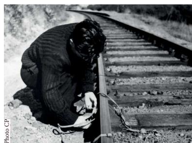
Pose d'un dispositif destiné à faire sauter une ligne de chemin de fer. Date inconnue. Copyright collection particulière.
