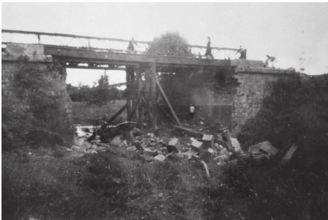
Installation d'un pont préfabriqué «Bailey» sur le pont de Guerieux détruit -Photo Joseph Lucia
