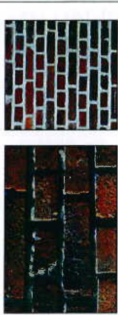
Exemple d'un mur rejointoyé
