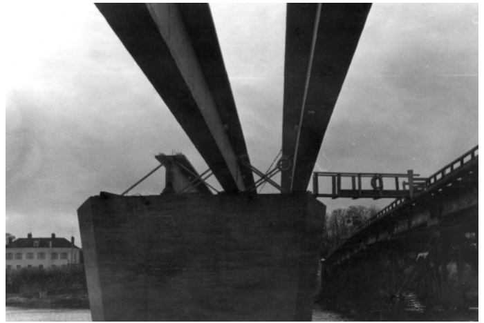
Mise en place des poutres
