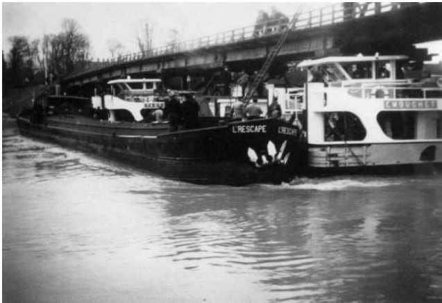
Réparation après une collision avec une péniche
