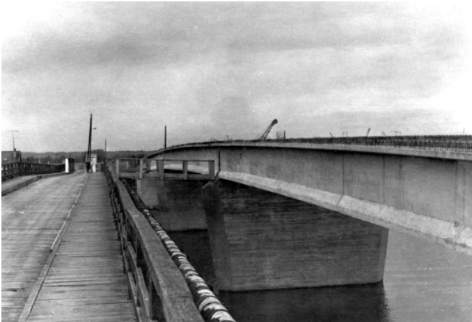
Cohabitation entre les deux ponts
