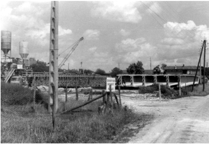
Préfabrication des poutres porteuses
