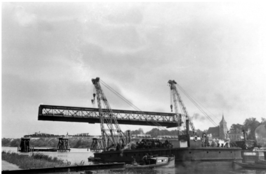
Construction du pont provisoire
