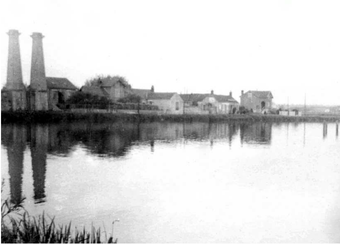
Les restes du pont suspendu en 1941
