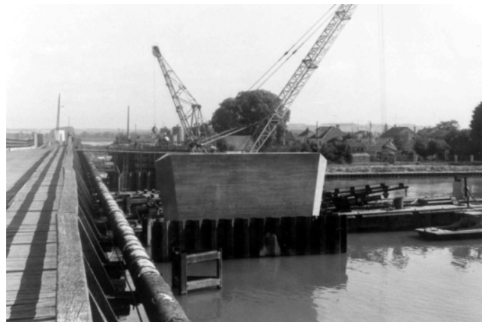
Pile sud terminée
