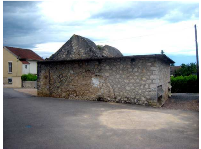
Massif d'ancrage des câbles porteurs
