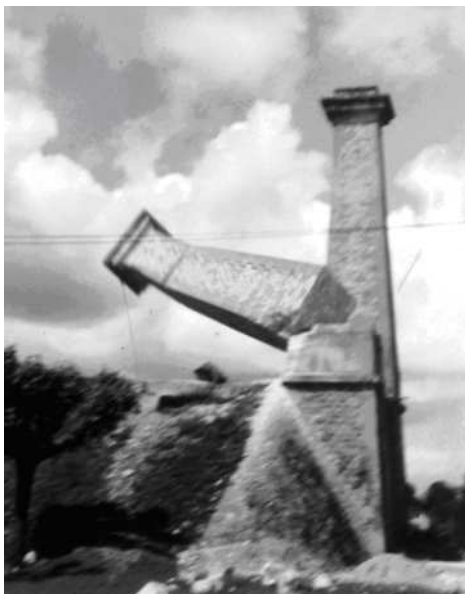
Destruction des pylônes de maçonnerie du pont suspendu
