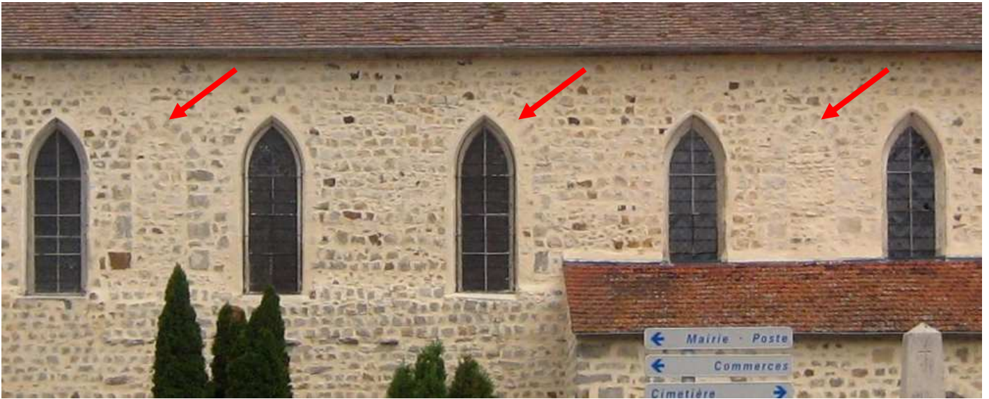
Remaniements des fenêtres côté sud
