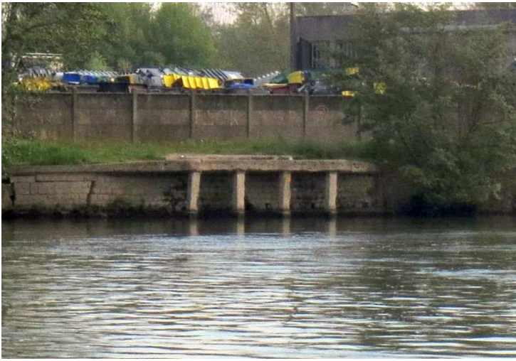
Quai de chargement
