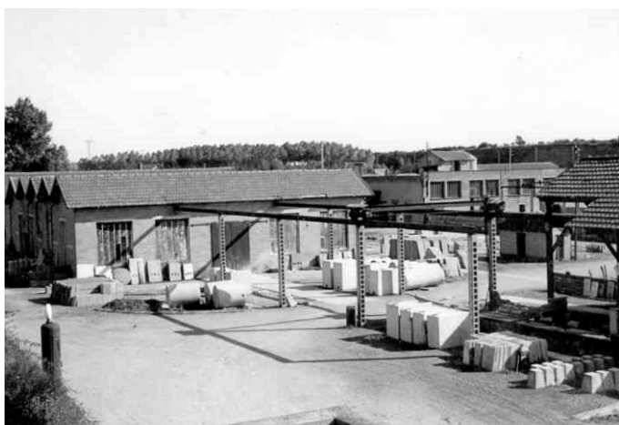
Vue générale de l'usine
