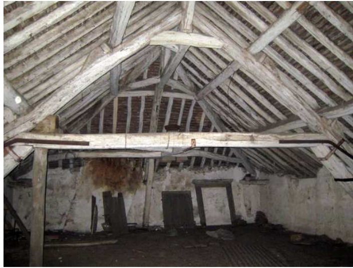
La charpente du moulin
