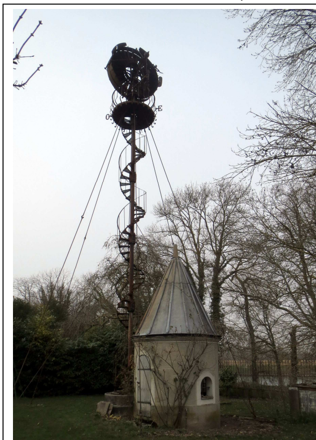
Vue générale de l'éolienne et du bâtiment de la pompe
