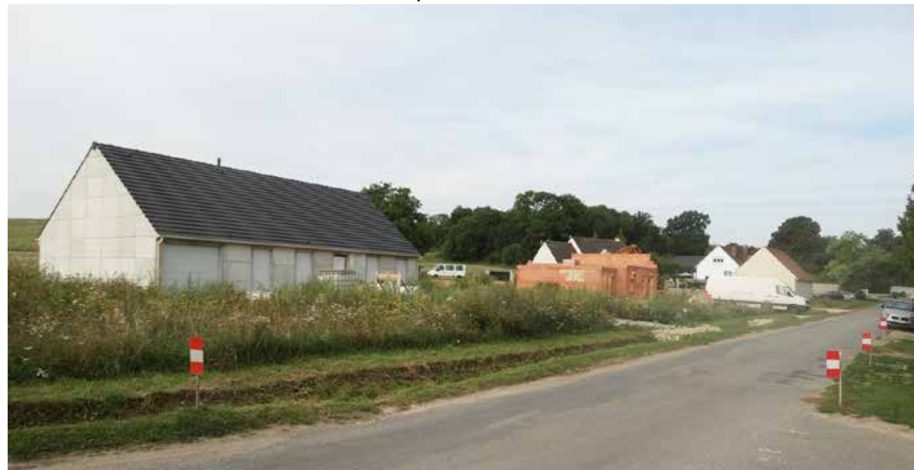
En limite est de Ducy, constructions à usage d'habitation en cours d'achèvement.
