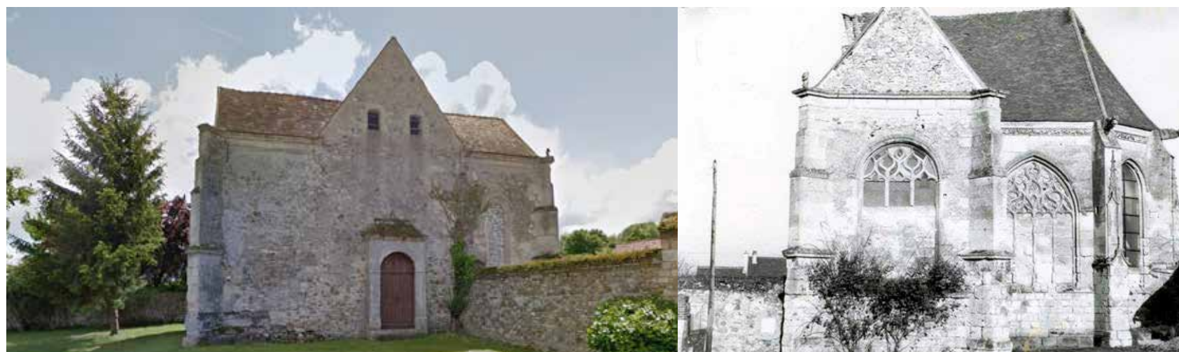
Chapelle du Luat (façade ouest à gauche, est à droite)
