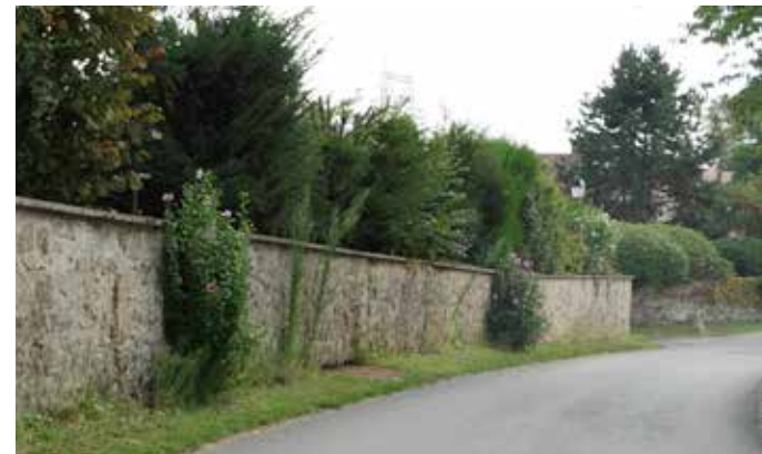
Murs en pierres à Ducy
