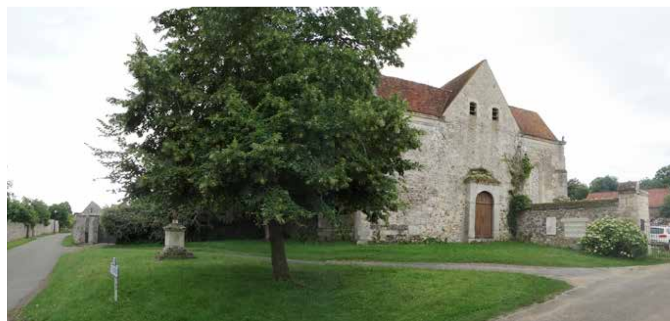
Vue sur la Chapelle de Le Luat et ses abords à valoriser.
