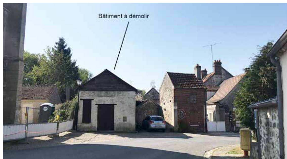
Vue sur la construction à démolir pour ouvrir l'espace aux abords immédiats de l'église de Fresnoy.
