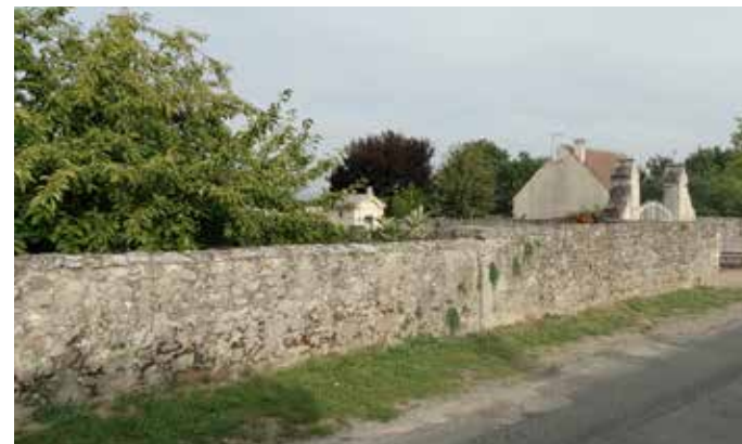
Murs en pierres à Fresnoy
