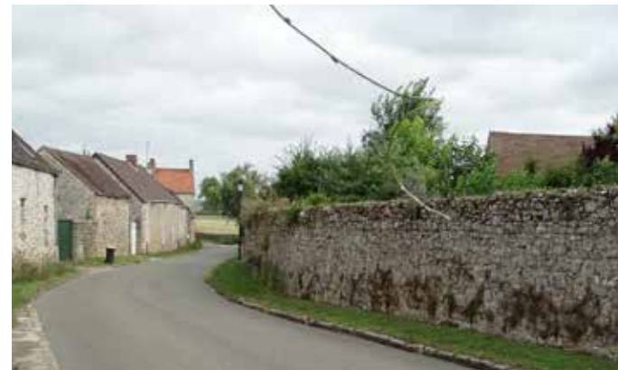
Murs en pierres à Ducy
