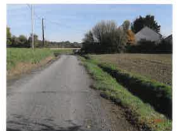
APRÈS les travaux
