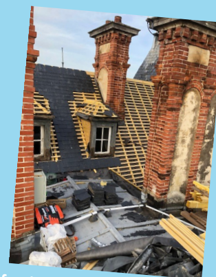
Réfection de la toiture du château
