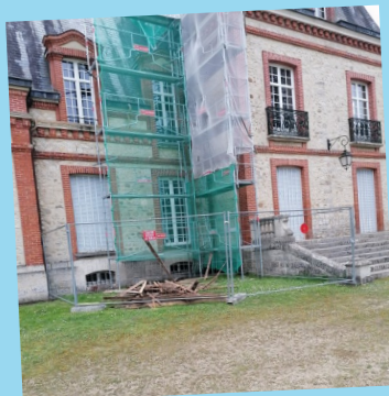
Réfection de la toiture du château
