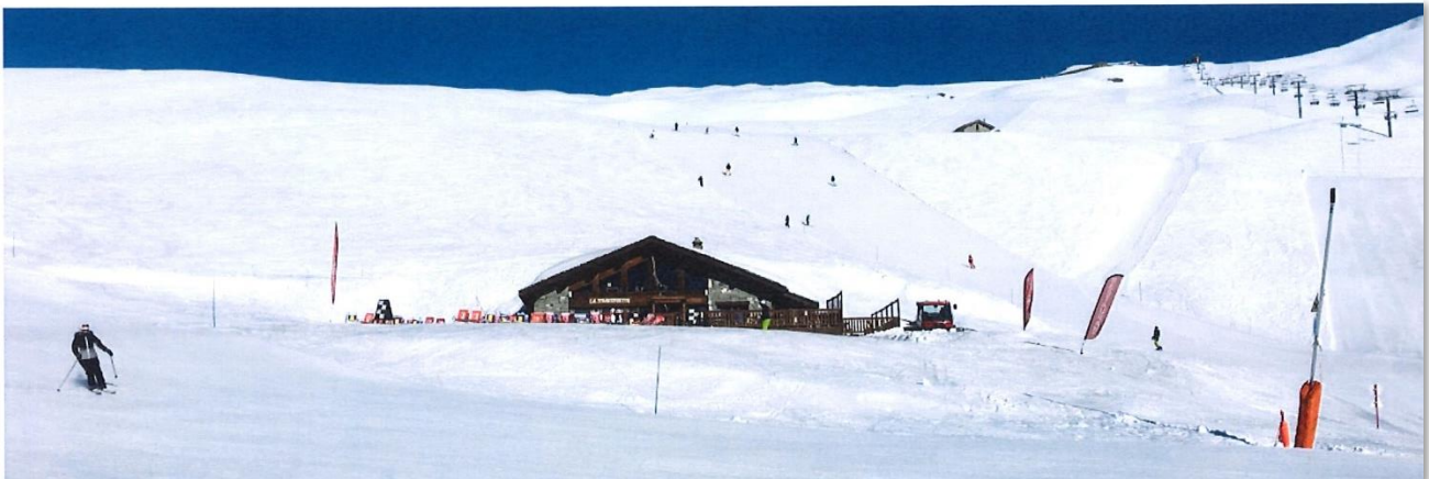
MATERIEL DE DENEIGEMENT STOCKE AUX ABORDS DU RESTAURANT D'ALTITUDE (ETAT DES LIEUX)
