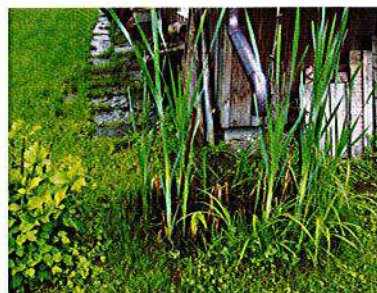
Aménagement pour un drainage naturel des eaux de pluie du toit
