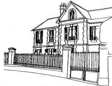
Les débords de toit, les avancées en pignon, les modénatures sont caractéristiques de ces maisons
