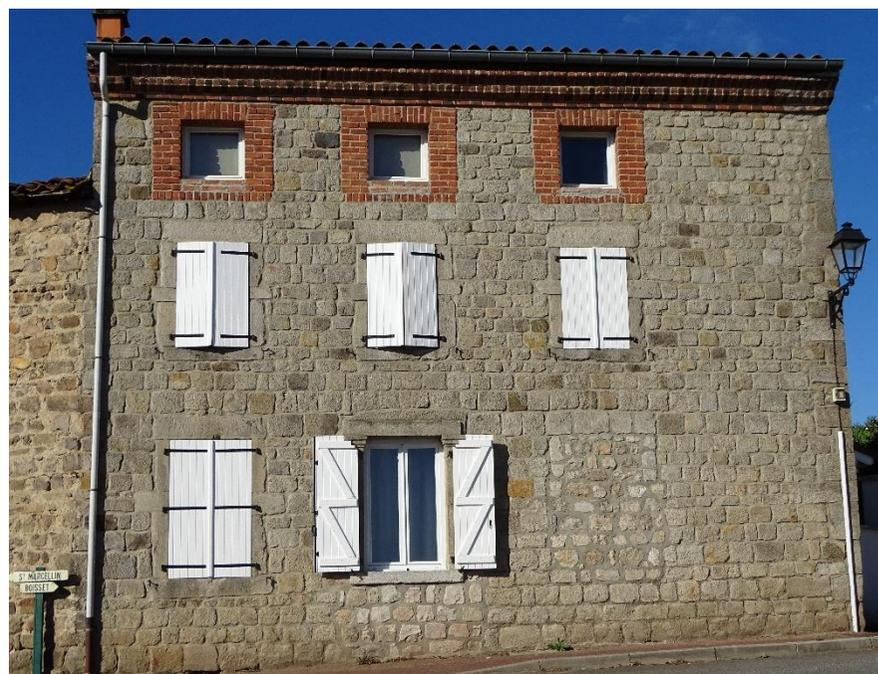
La partie habitation a été réalisée en pierres apparentes destinées à être vues (pierre de taille et/ou équarries avec des joints entre allant de 1 à 5 cm). Cette technique de construction exige le renforcement des encadrements d'ouverture et des chaînages en pierre ou en briques. A l'origine, la façade présentait une organisation symétrique
