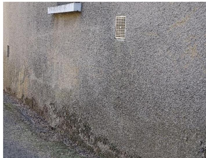
La combinaison d'un enduit au ciment hydrofuge avec une voirie bitumée jusqu'en pied d'immeuble emprisonne l'eau dans le mur du bâtiment sous forme de remontés capillaires qui déposent des sels minéraux dans toute l'épaisseur de la maçonnerie.
