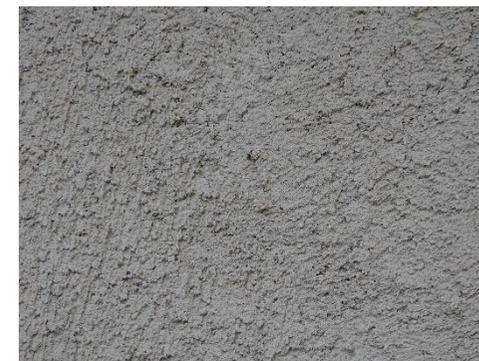
En duit plein en dégrossi terre-chaux (= chaux tendre) sur un mur en pisé. Finition tirée à la règle. Afin d'éviter que les raccords se voient, l'enduit doit être tiré le plus rapidement possible sur toute la surface du mur en une seule journée.
