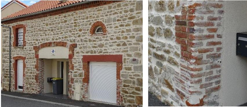
brique présente un rejointoiement approximatif de mauvaise qualité, avec une couleur de joint trop contrastante.
