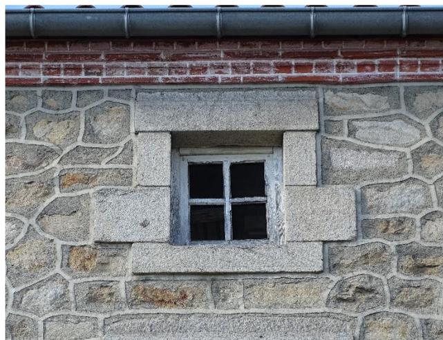
*Opus incertum* à joints rubannés : appareil irrégulier réalisé avec des moellons de pierre de dimension et de forme irrégulières, sans qu'on puisse distinguer une assise différenciée.
