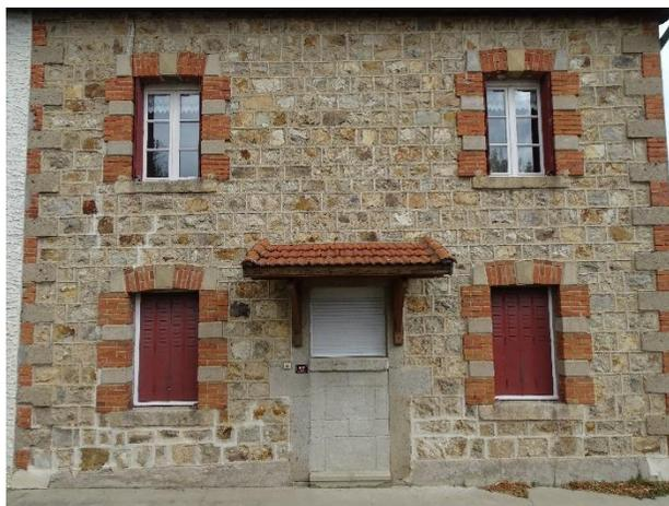
Les chaînages d'angle alternant brique et pierre sont particulièrement soignés et contribuent à amortir la déformation des murs.
