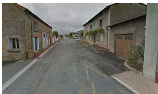
route de Bellevue : chaussée abîmée, trottoir interrompu...
