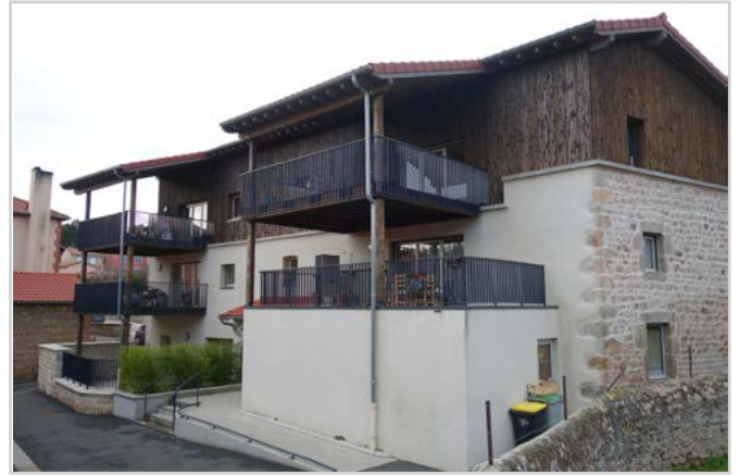
Rénovation d'un bâtiment, création d'une sur-élévation d'un étage et de terrasse à l'arrière. Luriecq (42), Cimaïse architecte.
