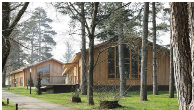
Salle des fêtes et salle des associations de Simandres (69) - Transformation des anciens ateliers municipaux - Atelier 43. Les bâtiments ont fait peau neuve grâce à de nouvelles façades en bois et des pignons largement ouverts sur l'extérieur.
