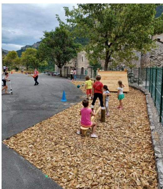
Cour de l'école primaire d'Enimie (48) - Cévennes Évasion et Hermabessière Paysage. La cour a été en partie décroutée pour retrouver des zones perméables.
