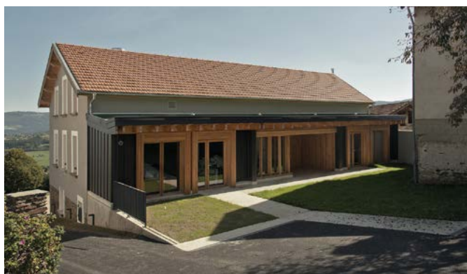
Salle des fêtes de Mayres - Réhabilitation + extension - Boris Bouchet architecte. L'extension permet de créer une façade dont le langage architectural fait appel et renvoie à l'esthétique d'un bâtiment public.
