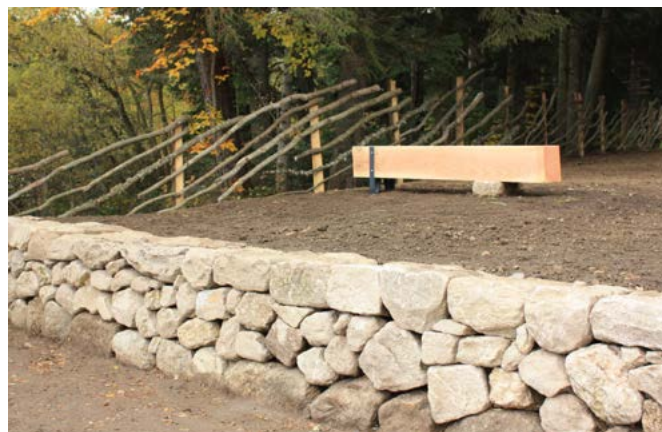
Lac Malaguet (63), mur soutènement pierre, Atelier Bivouac - ELIPS
