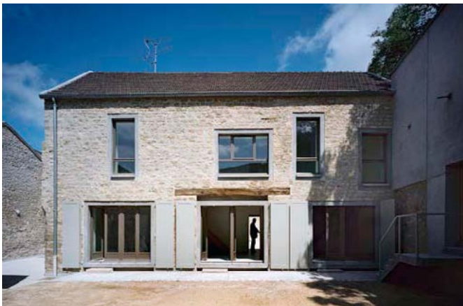
Réhabilitation d'une ancienne ferme de centre-bourg pour la création de 9 logements sociaux, Juziers (78)
