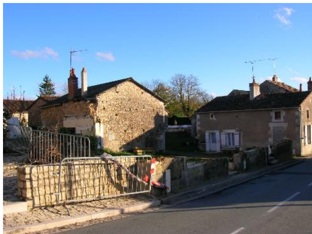
Après... la démolition
