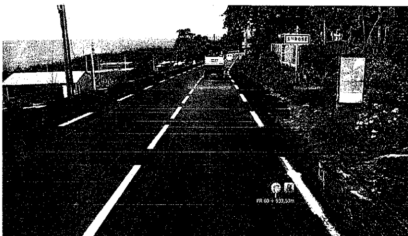
Identification: Images Avant Date: 13/04/2015 Localisation : 974 N0002(+) PR 60 + 932,53m; PR 61 - 66,68m
