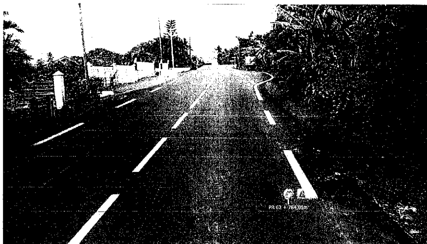
Identification: Images Avant Date: 13/04/2015 Localisation : 974 N0002(+) PR 62 + 783,01m; PR 63 - 200,48m
