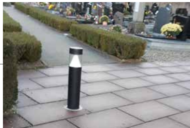
Eclairage du parvis de l'église
