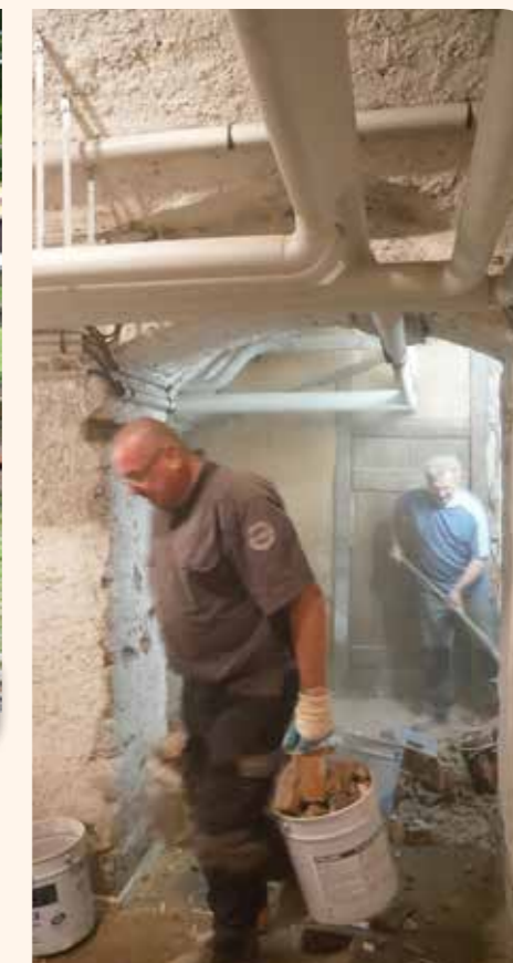
Trois courageux se sont attelés au local de stockage de la future bibliothèque. Entre démolition et nettoyage, ils ont terminé ce chantier recouverts de poussière.
