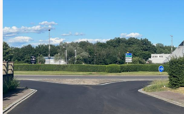
**Rue d'Italie, avant et après** : des travaux ont été engagés pour un montant de 99 900 euros TTC. La voirie a été intégralement refaite en janvier et février : écoulements d'eaux pluviales et le fond de forme de la voirie (assise de la route) ainsi que la chaussée sur environ 200 mètres.
