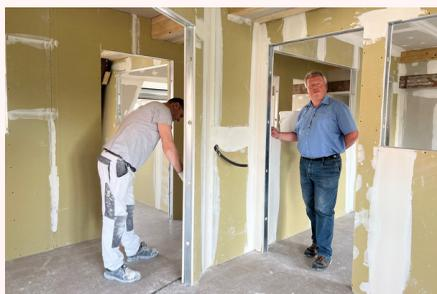
**Toujours en mairie au deuxième étage**, les travaux sont réalisés en régie et supervisés par Alexandra Zumbiehl sous la conduite de Gilles Ackermann. Les locaux du service des finances ont été intégralement rénovés. Après la pose de la dalle, place à la phase placo et isolation. La réception des travaux se fera à la fin du mois de juin 2022, en même temps que celle du local du personnel.
