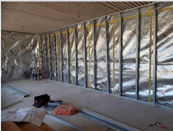
Mise en œuvre des doublages
