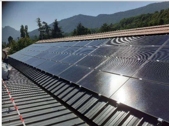
Pose des panneaux photovoltaïques
