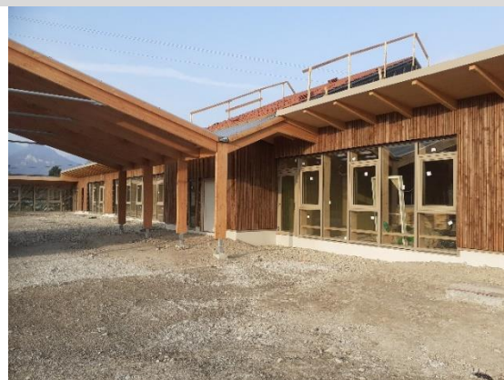
Pose du bardage en Douglas
