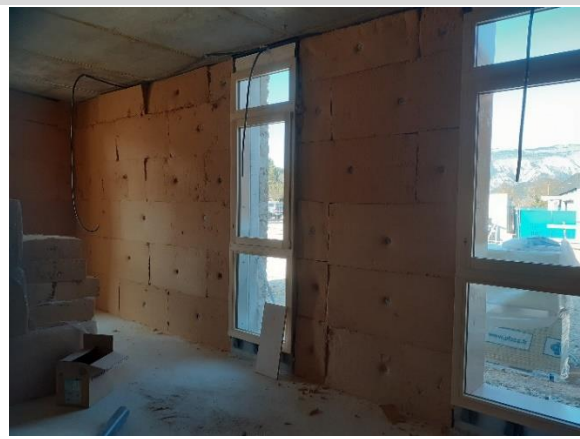
Mise en œuvre des doublages
