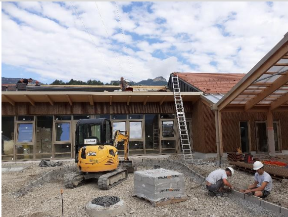
Aménagement des cours
