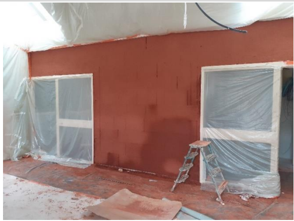
Enduits en terre sur le mur central
