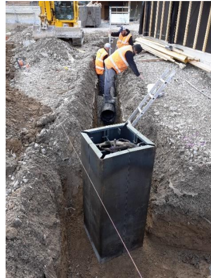
Mise en œuvre des réseaux d'eaux pluviales
