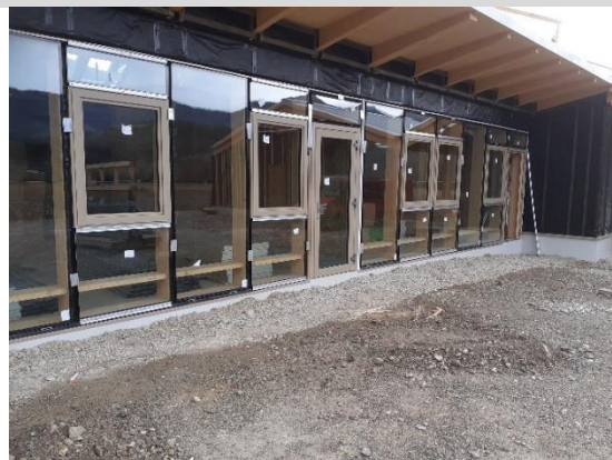
Pose des menuiseries extérieures
