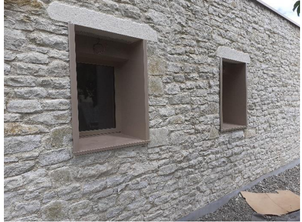
Encadrement en tôles des menuiseries extérieures
