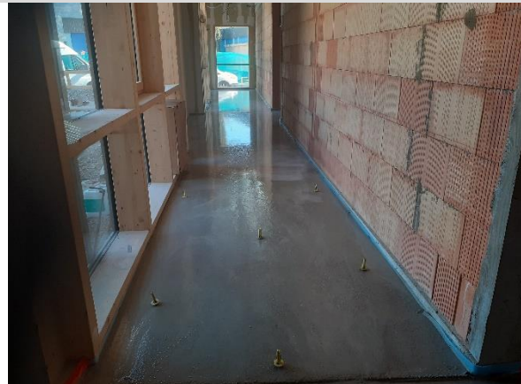
Isolant au sol et chape
