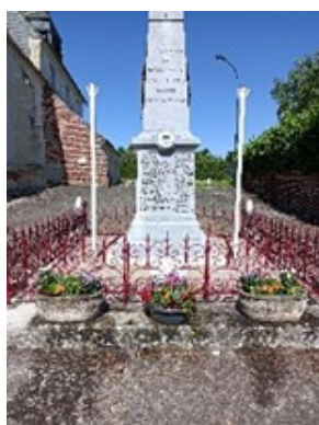
Rénovation terminée du Monument aux morts.
