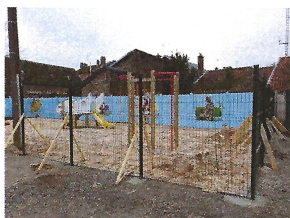
Pendant les travaux
