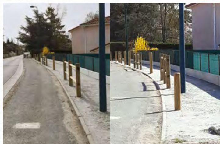
Fin du cheminement piétons sur la RD10 vers la Vange
