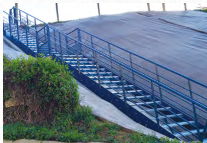
Remplacement des escaliers bois à côté de la mairie
