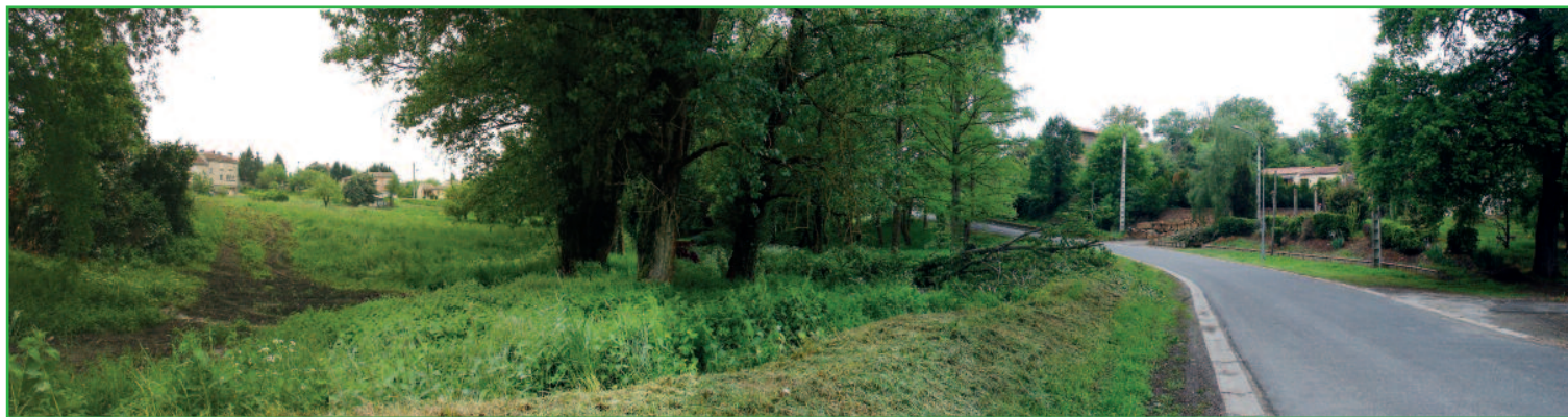
Exemple de fauchage retardé avec une passe de sécurité sur l'accotement de la chaussée
