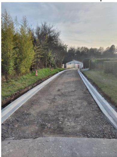
Début des travaux
