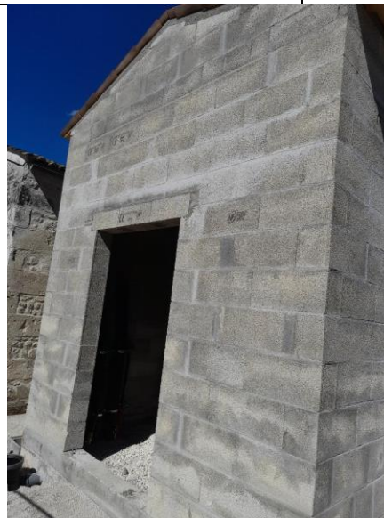
Bâtiment technique derrière la salle associative
