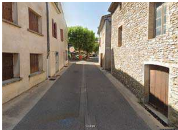
A l'entrée du bourg, un frontage possible en découpant les matériaux existants.
