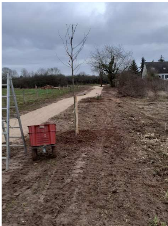
Aménagement chemin doux La Bardinière
