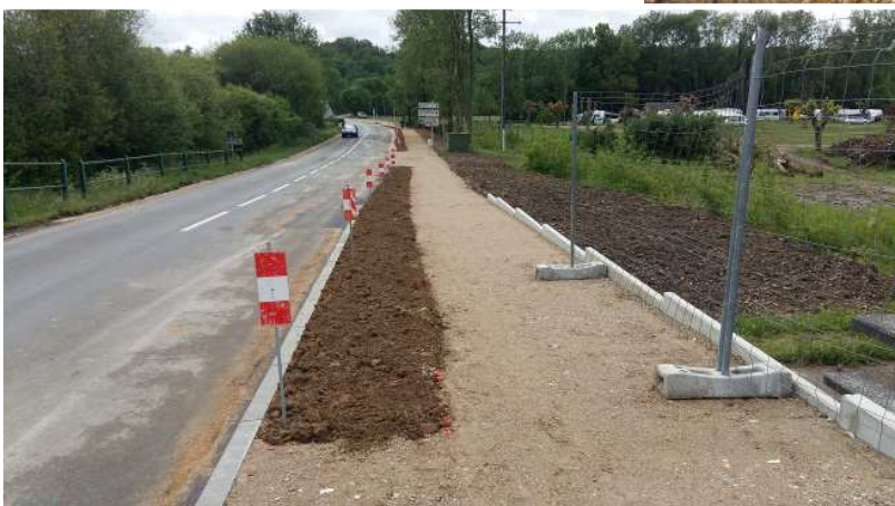
Aménagement chemin des Grenouilles
