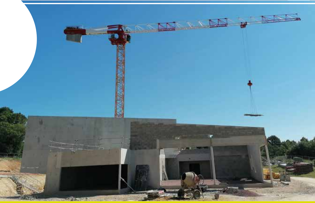
Chantier de la salle des sports
