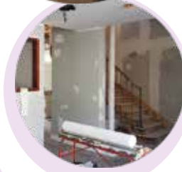
Visite du chantier de la mairie
