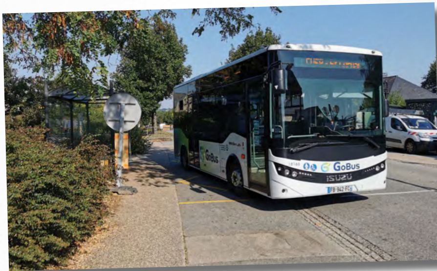
Réalisation de zébras aux arrêts de bus
