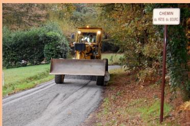
Les travaux consistent à mettre la chaussée hors d'eau, par une remise en état des fossés, la pose de canalisations d'eaux pluviales, l'empierrement et la pose d'un revêtement bi-couche.
