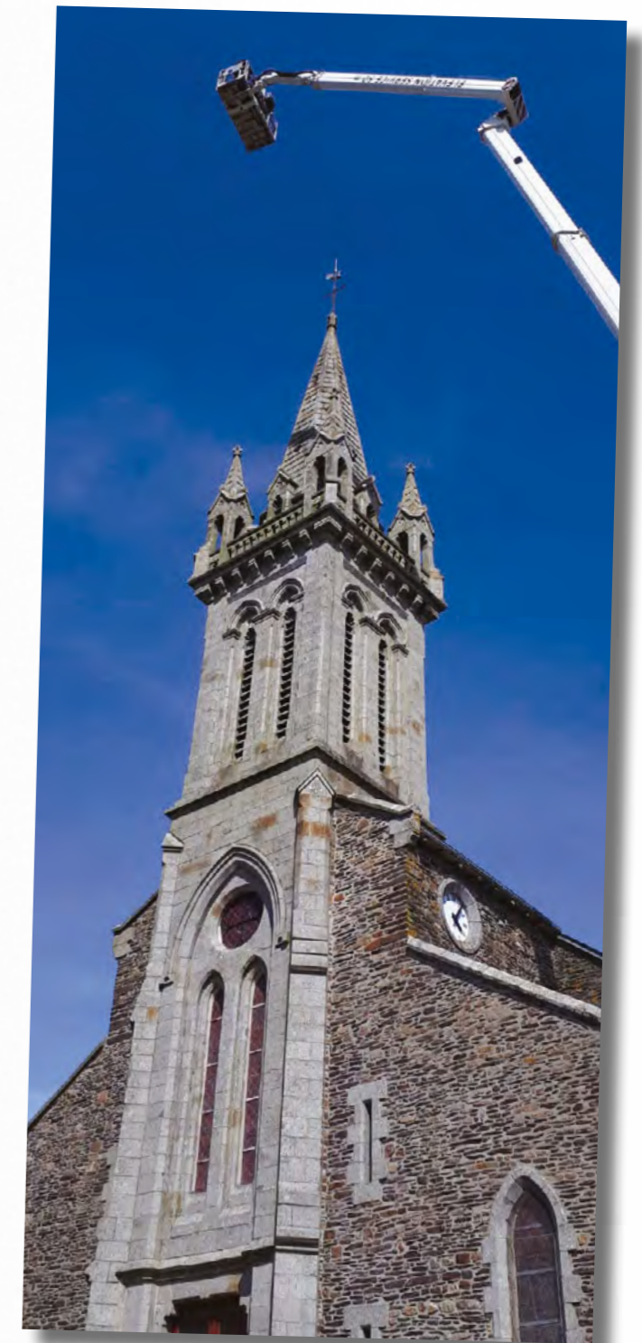
Travaux sur le clocher de l'église
