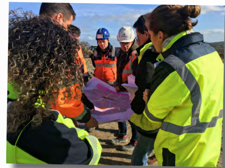
Réunion de chantier au lotissement. Commercialisation en juin 2022
