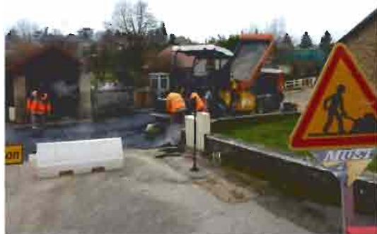
Février: travaux rue Neuve
