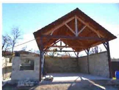
Novembre: aménagement du garage des Mangettes
