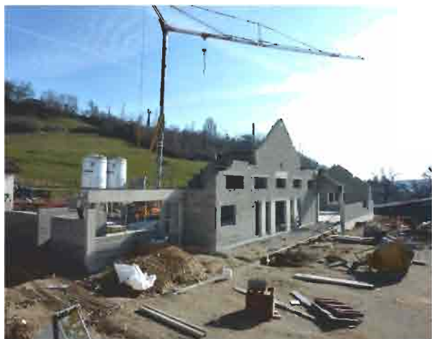
Mars: travaux salle des fêtes
