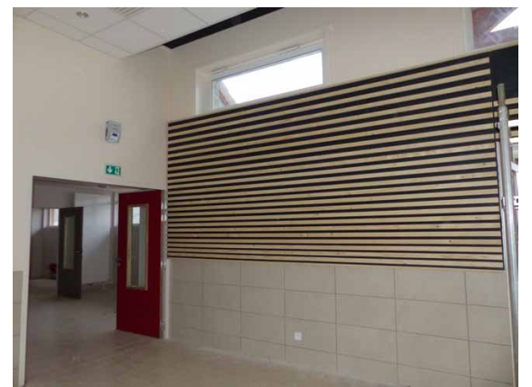
Pose de panneau acoustique
