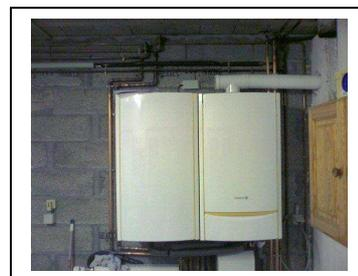
Lors de la visite, le diagnostiqueur a préconisé le remplacement de la chaudière fuel d'origine par une chaudière à condensation plus l'installation d'une ventilation.
