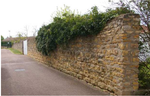
Mur Ouest dans la partie Nord du chemin
