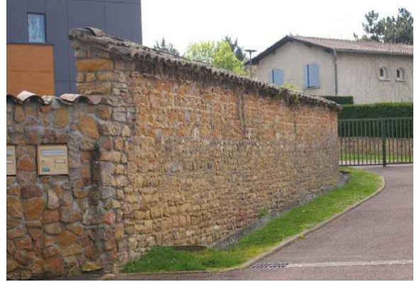
Mur Est proche du Parc municipal Guillemet
