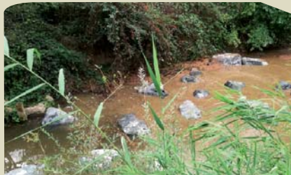
Pose de blocs dans le lit
