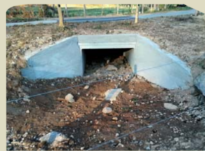
Nouvel ouvrage busé
