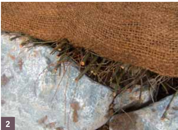
2 Boudin des plançons vu de près juste au dessus du dernier rang de blocs
