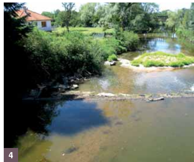
Enlèvement et colmatage du lit du Sornin à l'amont d'un ouvrage ; perte de débit dû à l'ouvrage réduisant la remobilisation des alluvions juste à l'aval : le banc se végétalise.
