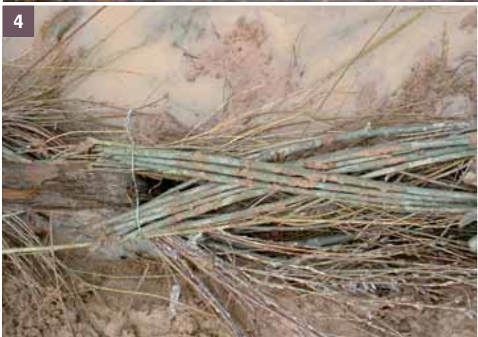
3 et 4 Vue de dessus d'un tressage avant dernier battage mécanique des pieux et coupe propre de leur extrémité, puis remblaiement au dos de l'ouvrage val
