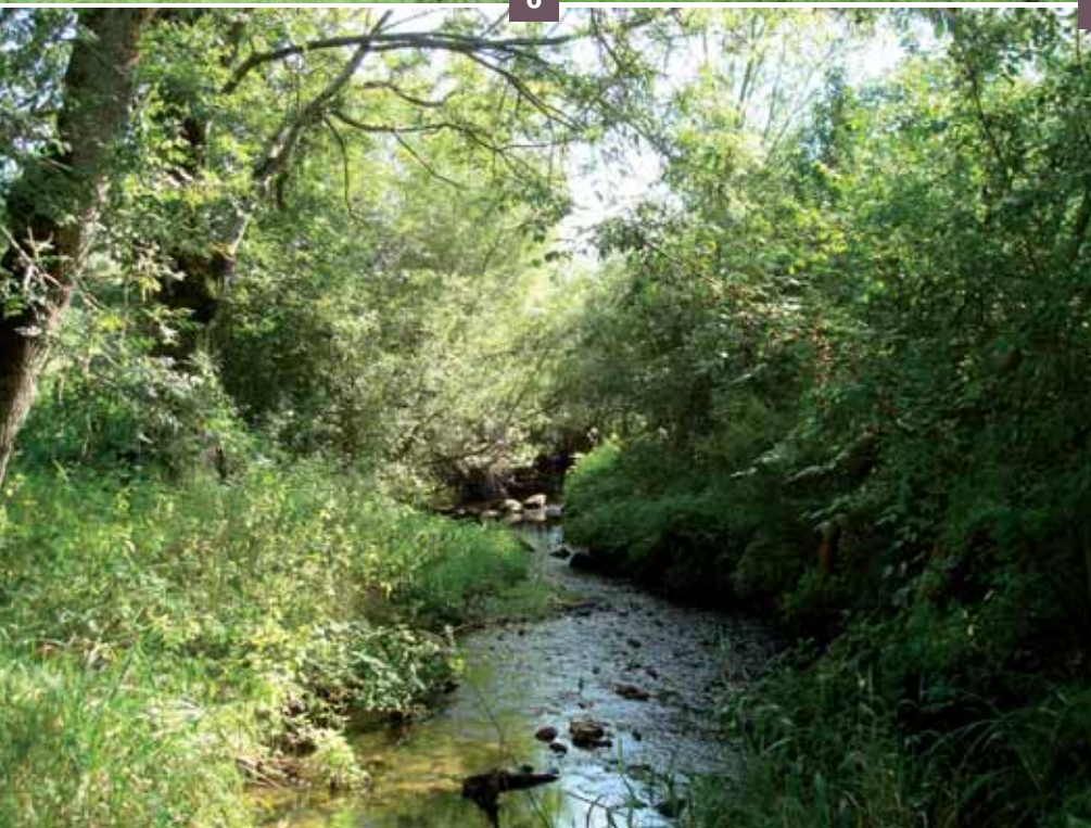
6 Vue du site enroché 8 ans après à l'extérieur des méandres et vue de l'intérieur du cours d'eau. Le pied de berge est consolidé et la végétation apporte tout ce que l'enrochement pur n'aurait pu faire seul
