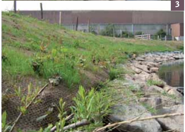
3 Vue après la fin de la mise en œuvre et début de la reprise végétative
