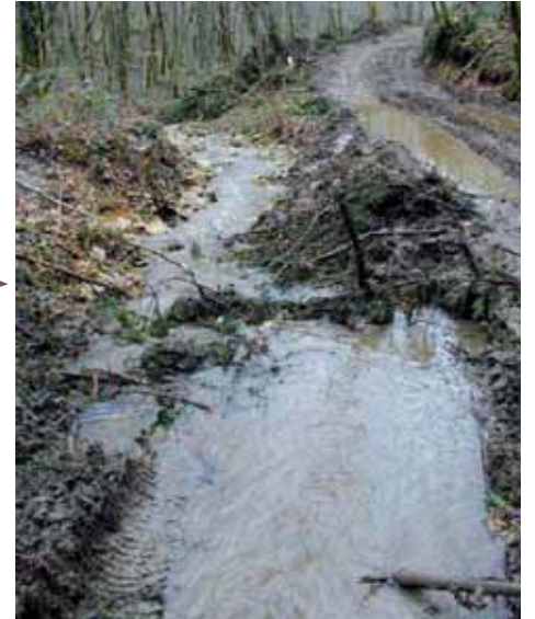
Départ important de matières en suspension (MES) lors d'un franchissement d'un ruisseau sans aménagement préalable
