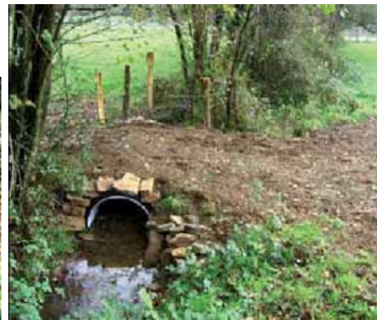
Passage en PEHD terminée
