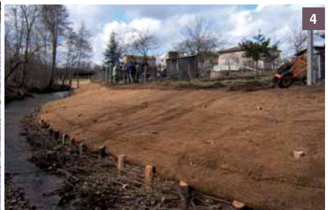
4 Le site en fin de travaux
