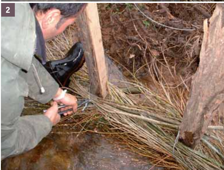
1 et 2 Tressage des branches de saules et ligaturage autour des pieux, La base des branches dirigée vers l'intérieur du talus, les extrémités des ramilles tournées vers l'aval
