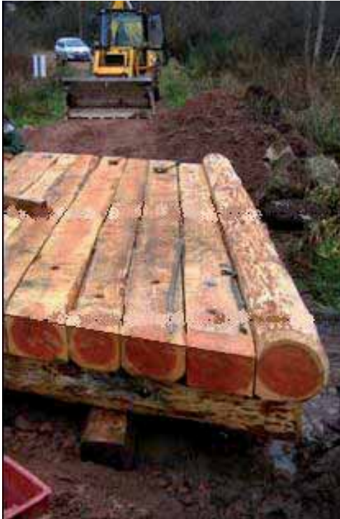
Passerelle en bois en phase de conception
