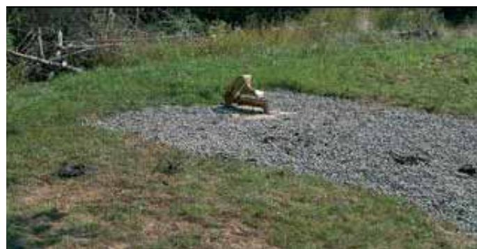
Aménagement des abords de la pompe en gravier pour assainir
