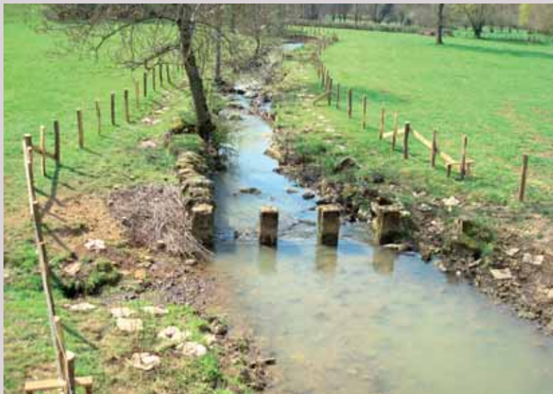
Clôtures et plantations. Un effet plan d'eau lié au seuil est encore ici présent - Avril 2010
