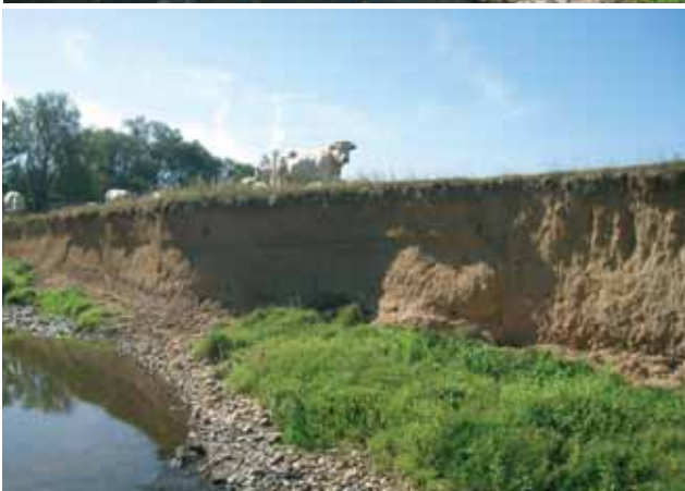
Érosion accentuée ici par une mauvaise gestion des berges
