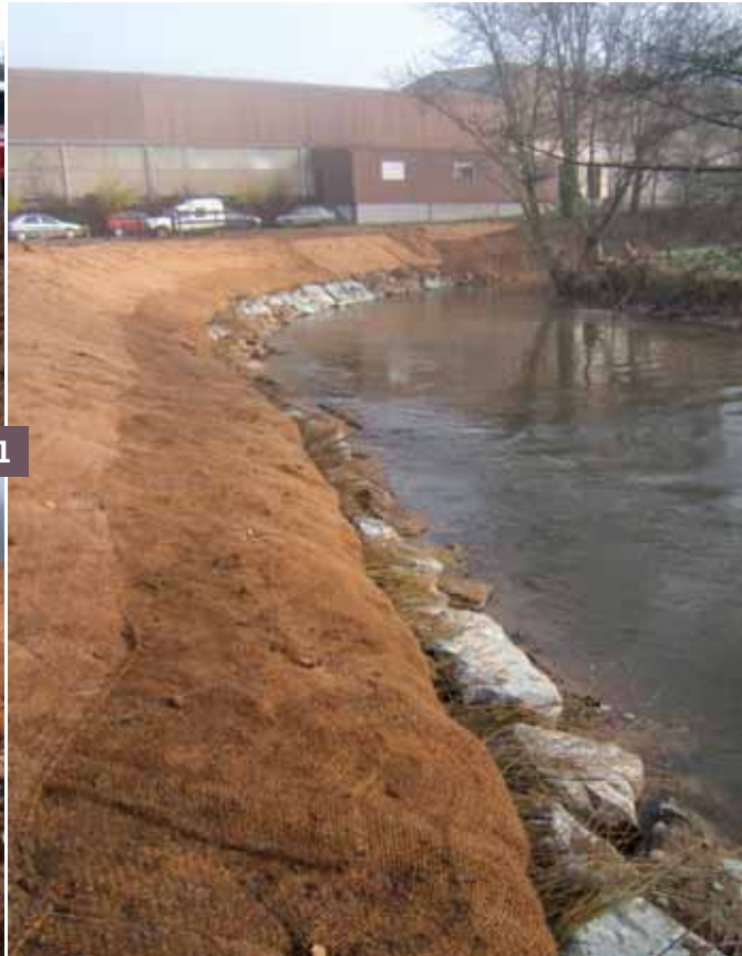
1 Mise en place d'un enrochement en pied de berge accompagné d'un seul rang de plants et plançons sur le dessus
