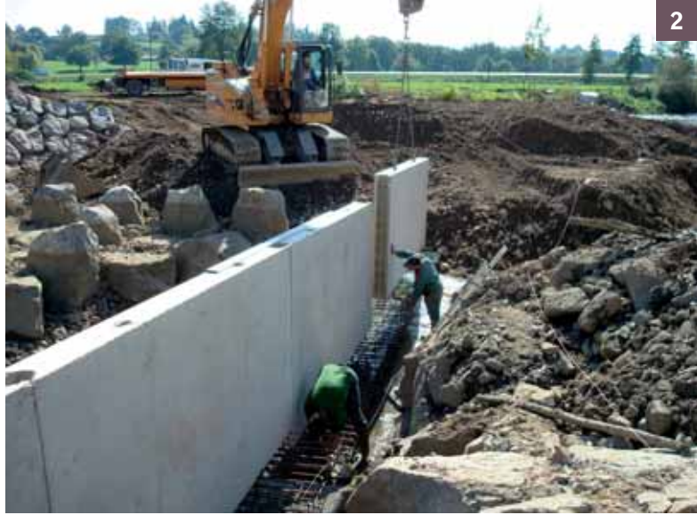
2 Installation du mur de soutènement de la passe
