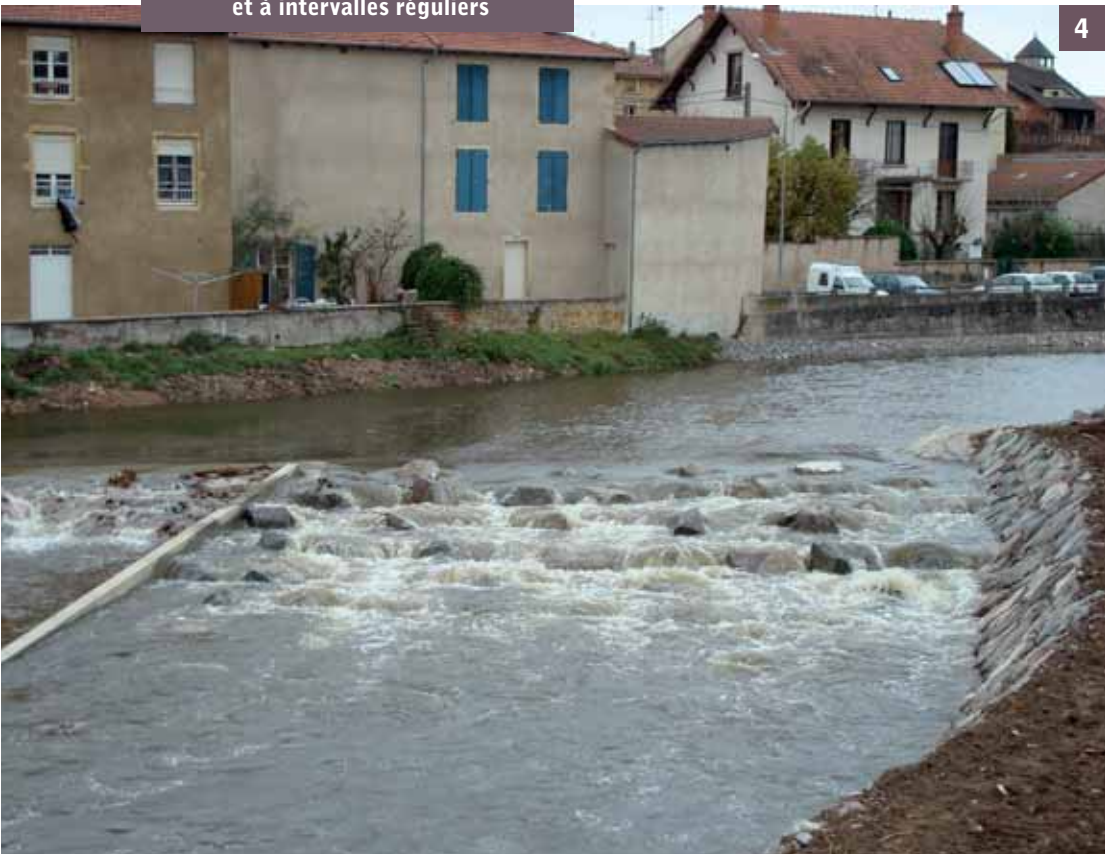
4 Ouvrage terminé, en eau
