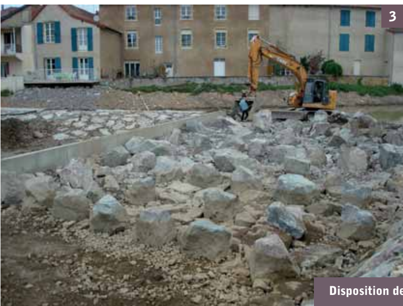
3 Fin d'installation de la passe jusqu'à la crête de l'ouvrage
