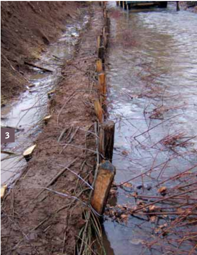
3 Confection de la fascine avec noyau terreux perpendiculaire au cours d'eau et avant l'arrivée de la fascine
