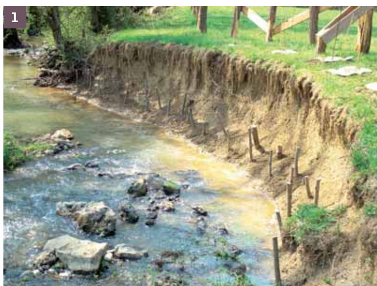
1 Bouturage sur encoche d'érosion
