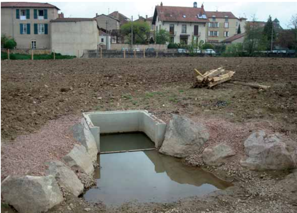
Fosse de réception d'un abreuvoir branché sur la rivière par vase communicant
