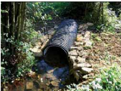
Arche en PEHD en cours d'installation
