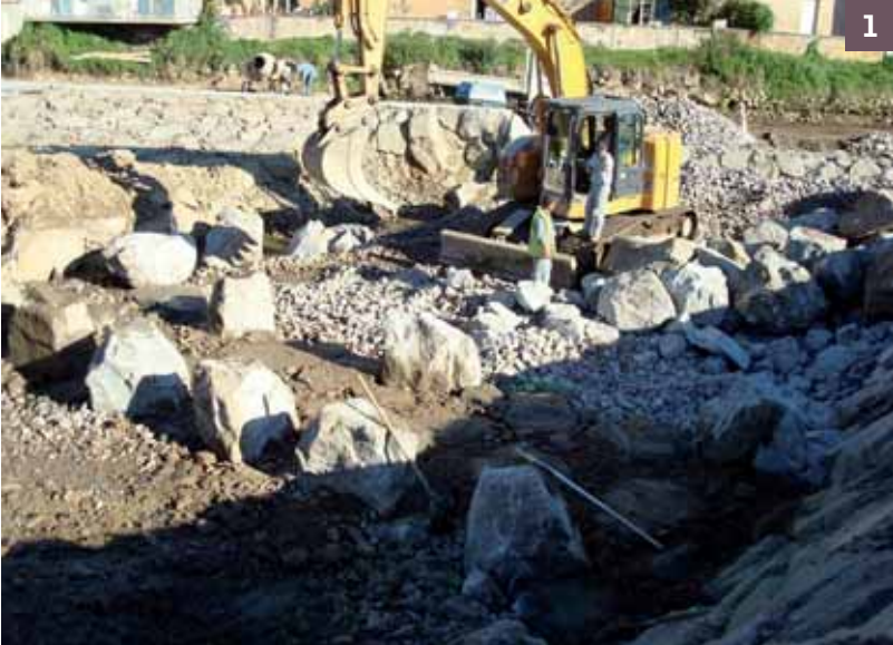
1 Aménagement de la passe à poissons et disposition des blocs à la pelle
