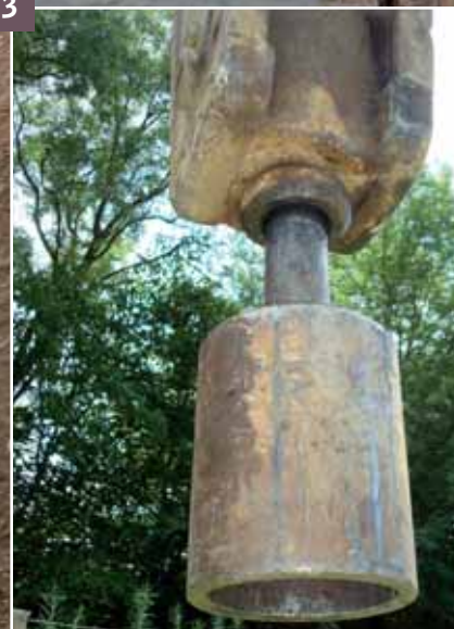
3 Installation et battage mécanique des pieux de la fascine - Cloche de battage montée sur brise roche de pelle
