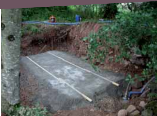
Stabilisation de l'ouvrage
