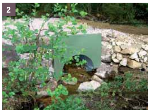
2 Passage avec arche métallique autoportée
