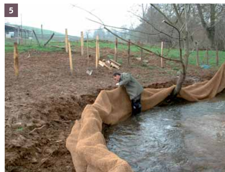
5 Mise en place du lé de géotextile
