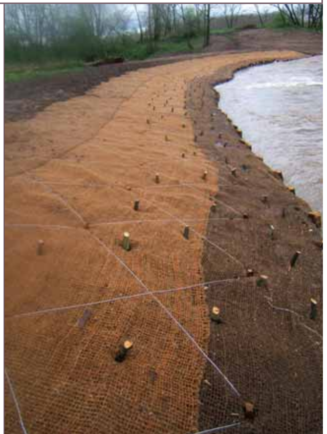
Armature en fil galvanisé du talus aménagé
