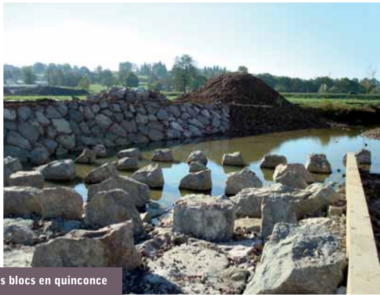
2 Installation du mur de soutènement de la passe
