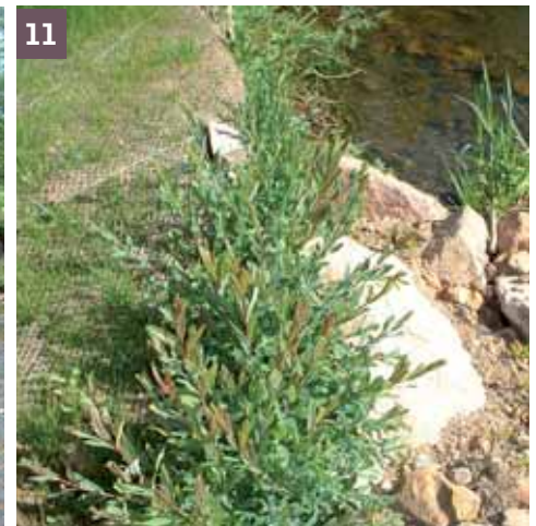
10 et 11 Reprise et apparition des premières tiges du tressage en façade et en crête de l'ouvrage
