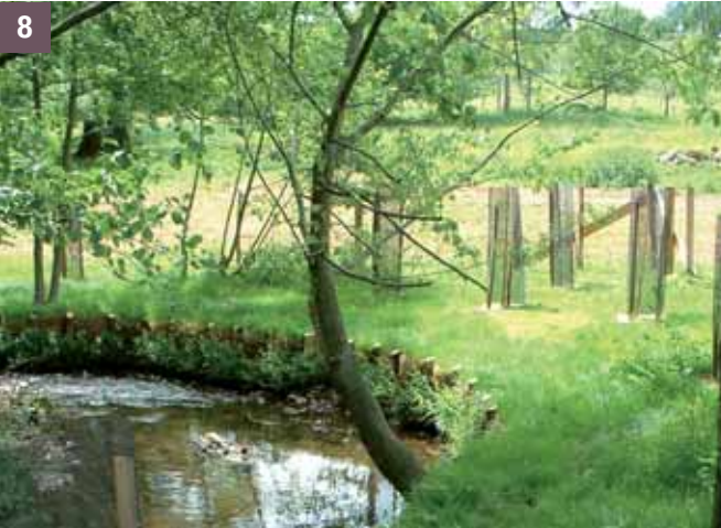
8 et 9 État d'un tressage de saules en pleine période de végétation juste après la fin des travaux
