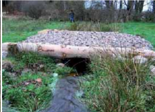
Passerelle bois et remblai de matériaux concassés
