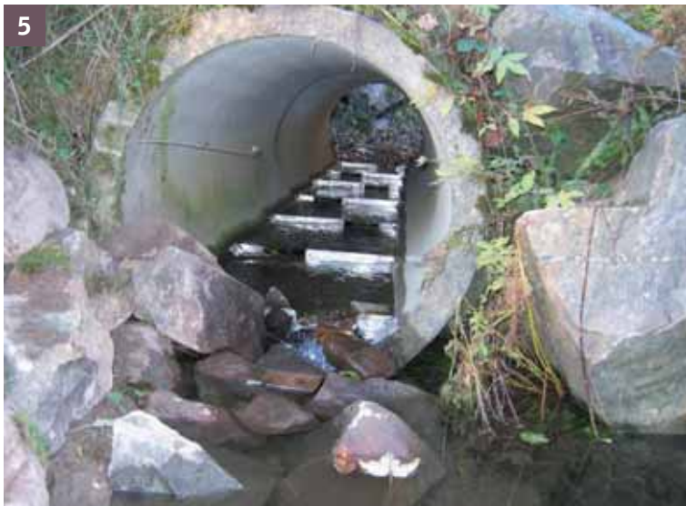
5 Seuils intérieurs de la buse mis en place. Résultat = diminution de la vitesse voir création d'un courant nul par endroit, augmentation de la lame d'eau même en période d'étiage.
