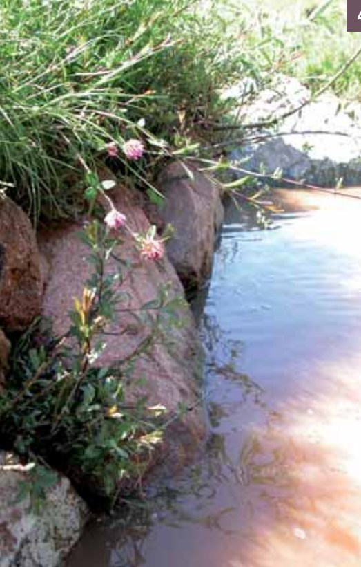
4 Reprise des boutures dans les interstices des blocs et du rang de plançons
