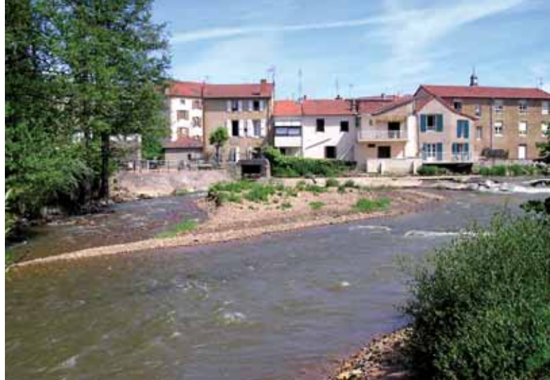
Bancs alluviaux, non mobilisables par les crues du fait de la présence d'un ouvrage transversal sur Charlieu. La végétalisation de l'atterrissement sera favorisée
