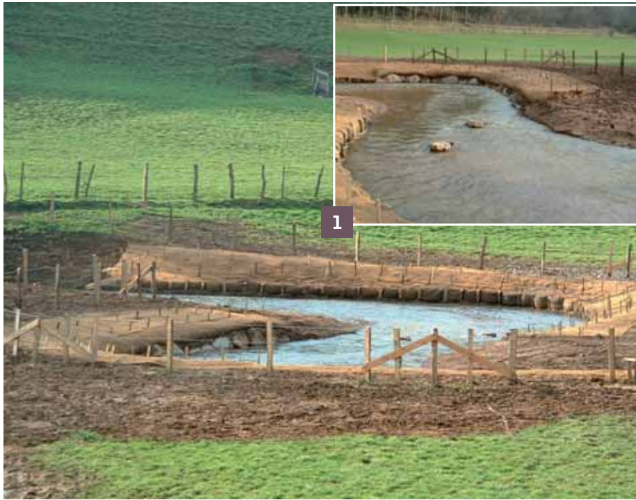
1 Confortement de méandres à l'aide en partie de fascine de saules
