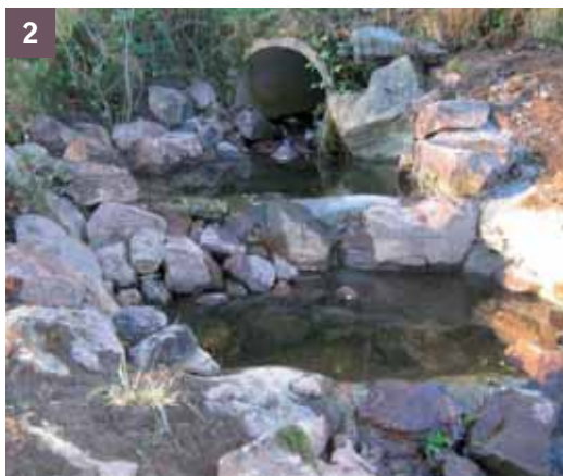
2 Passage busé APRÈS aménagement de pré-bassins pour résorber le dénivelé aval de la buse
