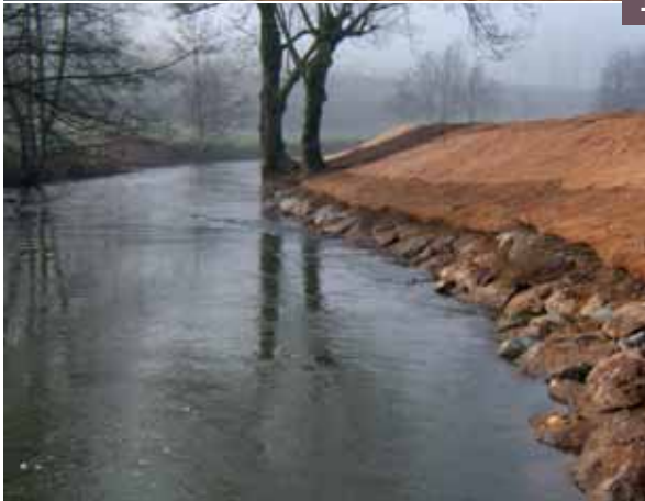
1 Mise en place d'un enrochement en pied de berge accompagné d'un seul rang de plants et plançons sur le dessus
