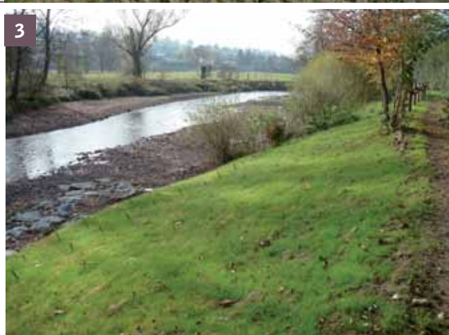
2 et 3 Début de reprise de l'ensemencement placé ici sous et en accompagnement d'un géotextile biodégradable
