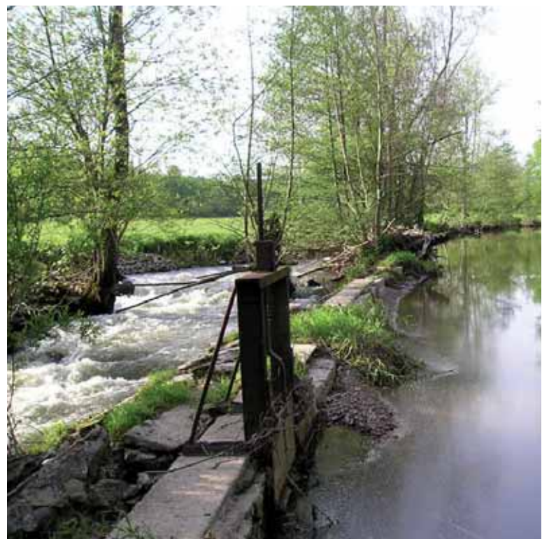
Seuil sur le Sornin à St Maurice les Châteauneuf : homogénéisation des faciès d'écoulement dans la retenue du seuil
