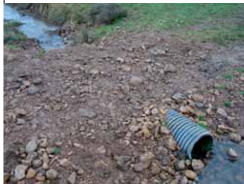
Décapage progressif de la buse
