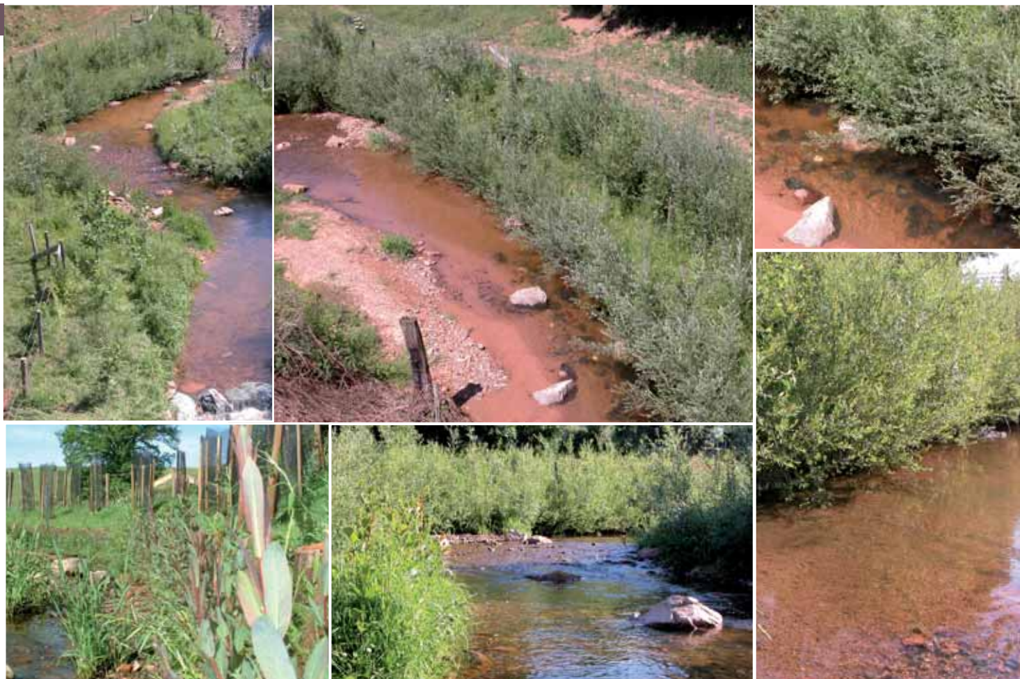
1 Le site quelques mois après la fin des travaux et en pleine reprise végétative. Le lacis de tiges externes créé est suffisamment dense et souple pour jouer un rôle de dissipation d'énergie sur les courants
