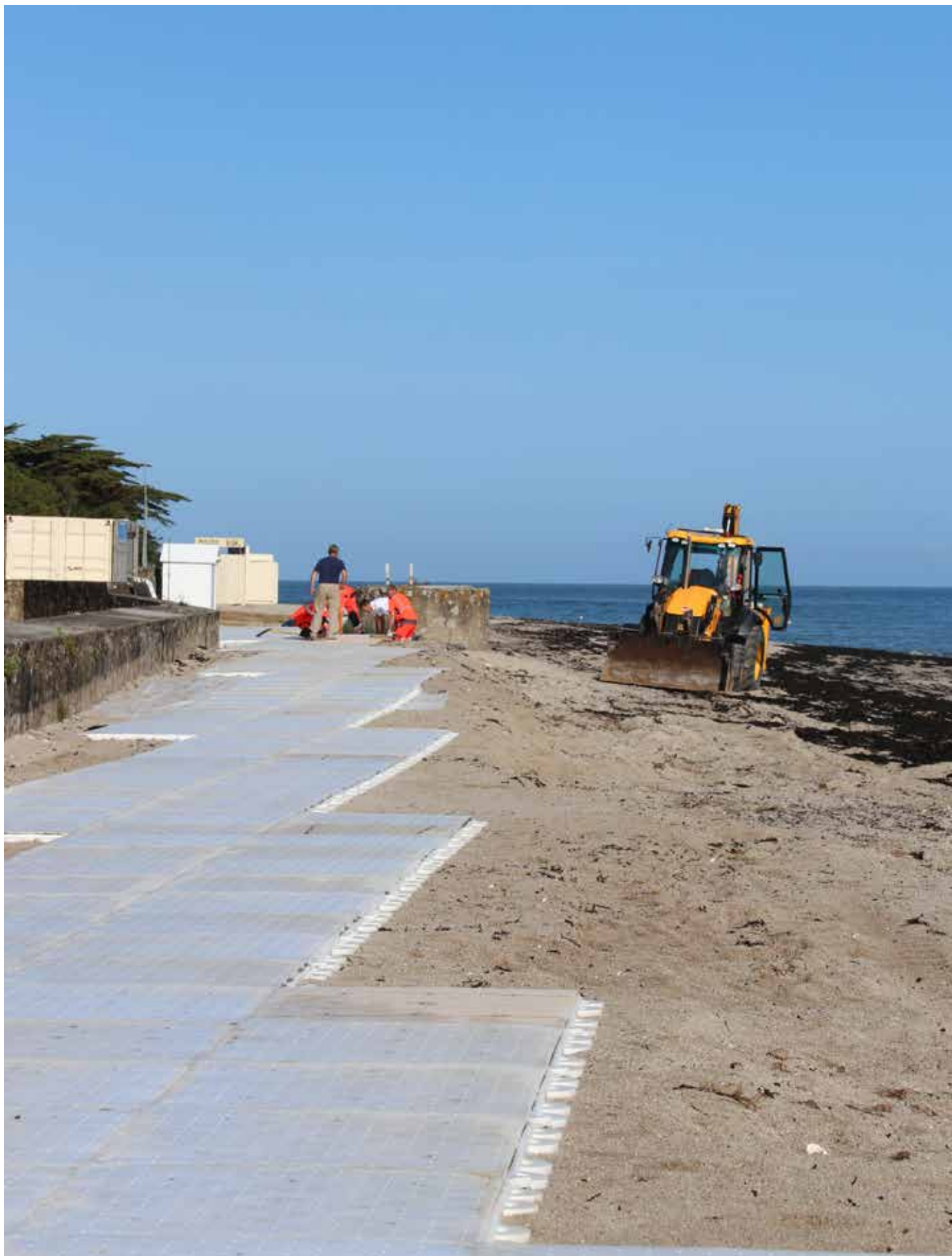
6 agents municipaux sont mobilisés pour installer les 220 m 2 de cheminement.
