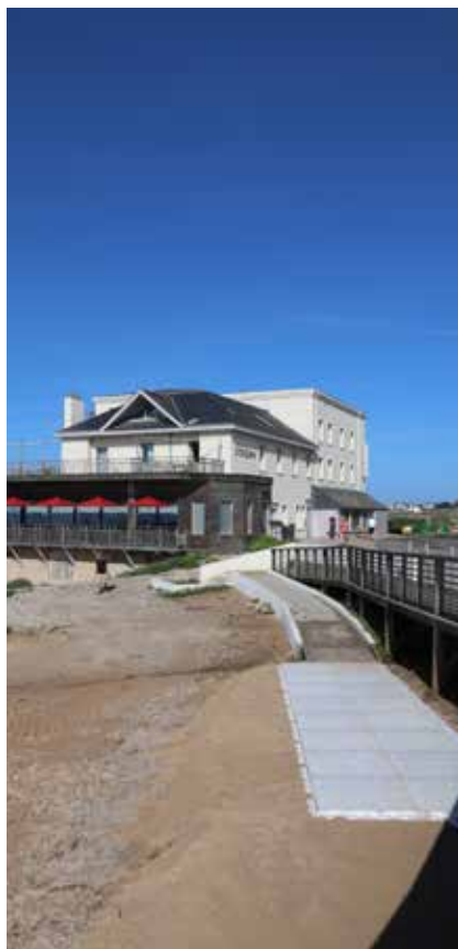
La rampe d'accès de la plage de Port-Lin bénéficie aussi d'un cheminement allongé de 17 m.
