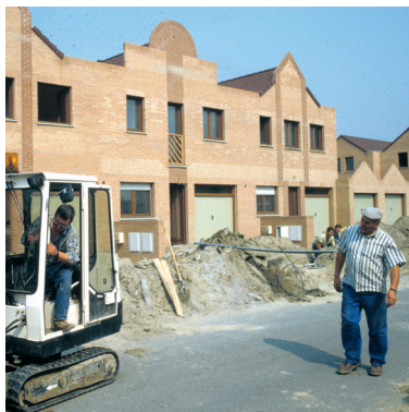
Construction quartier du Moulin à Grande-Synthe
