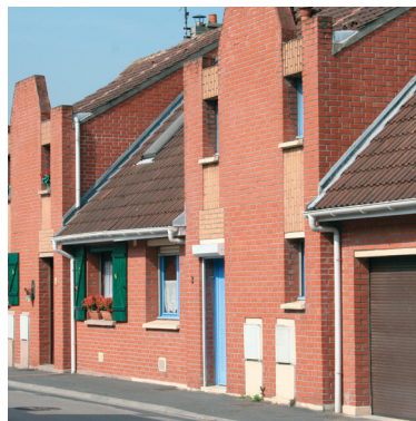
Logements locatifs sociaux en individuels à Téteghem
