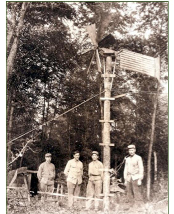
Éolienne actionnant une scie à bûches (1917)
