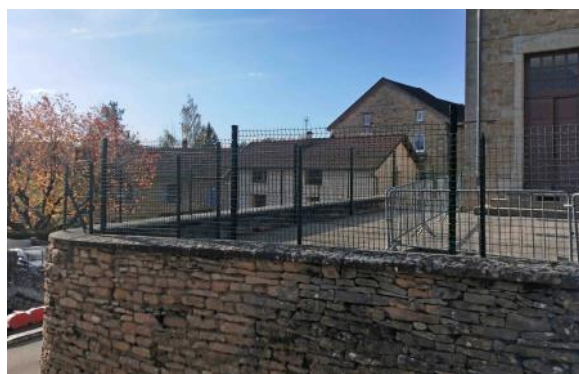
Renforcement de la clôture de l'école
