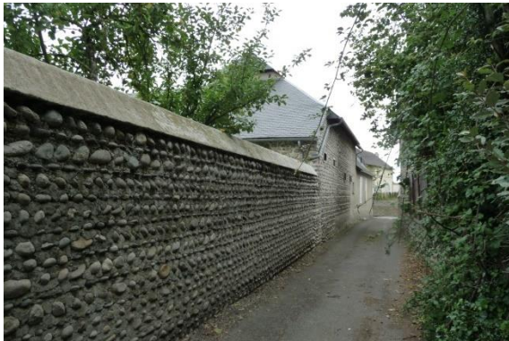
Mur de clôture en galets
