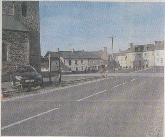
La fin des travaux du centre bourg approche
