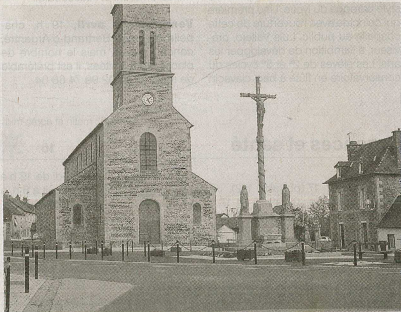
Le chantier du centre bourg sera terminé avant l'été, les travaux de restauration de l'église Saint-Eloi seront achevés à l'automne
